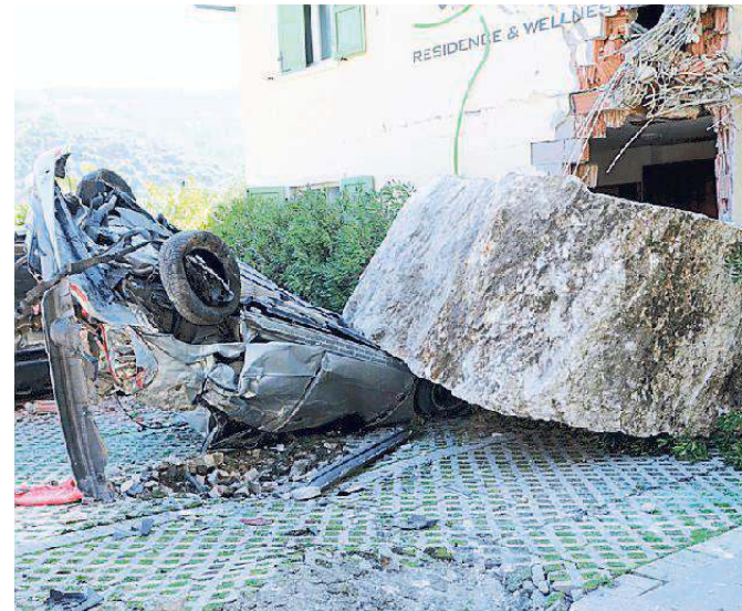
Uno dei massi della frana staccatasi dal monte Brione
